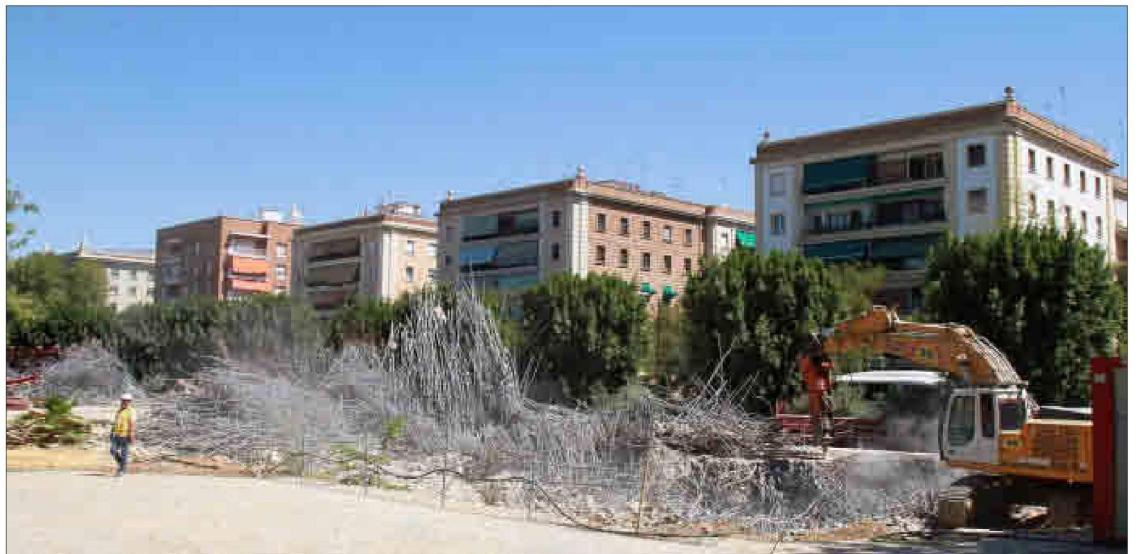
Trabajos de demolición de la estructura del edificio en septiembre de 2012, tras la orden judicial que obligaba a devolver los suelos a su estado original. c. MÁRQUEZ
