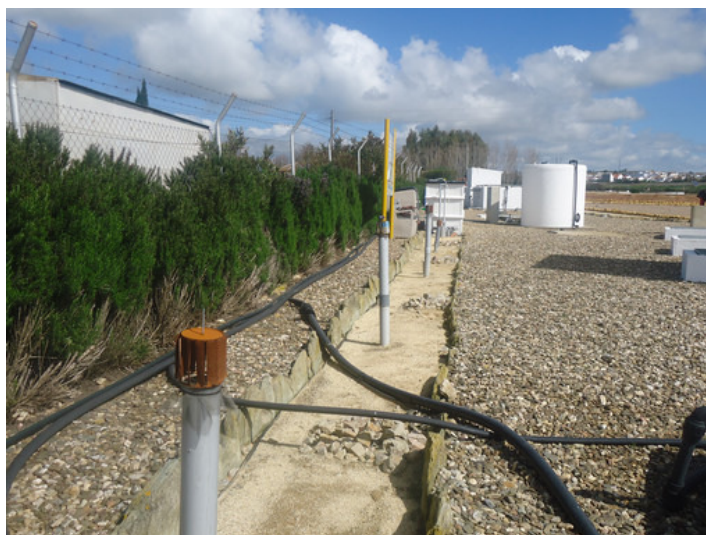
Canal de saneamiento hecho con piedras y escombros. / US
