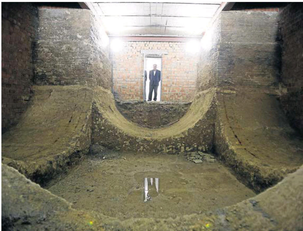
Miguel González Vílchez contempla la bóveda que permitió descubrir los arcos que sustentan la sede del Rectorado de la Universidad. / Pepo Herrera
