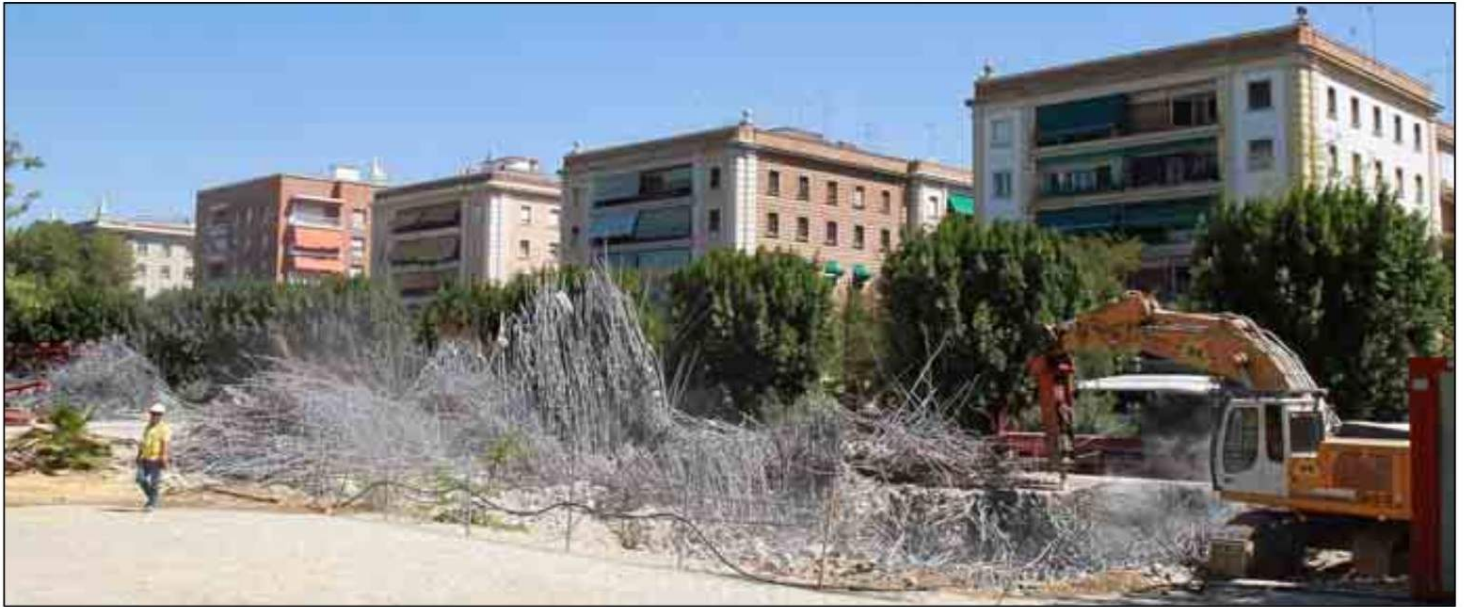
Trabajos de demolición en las obras de la biblioteca universitaria, en septiembre de 2012. / CARLOS MÁRQUEZ
