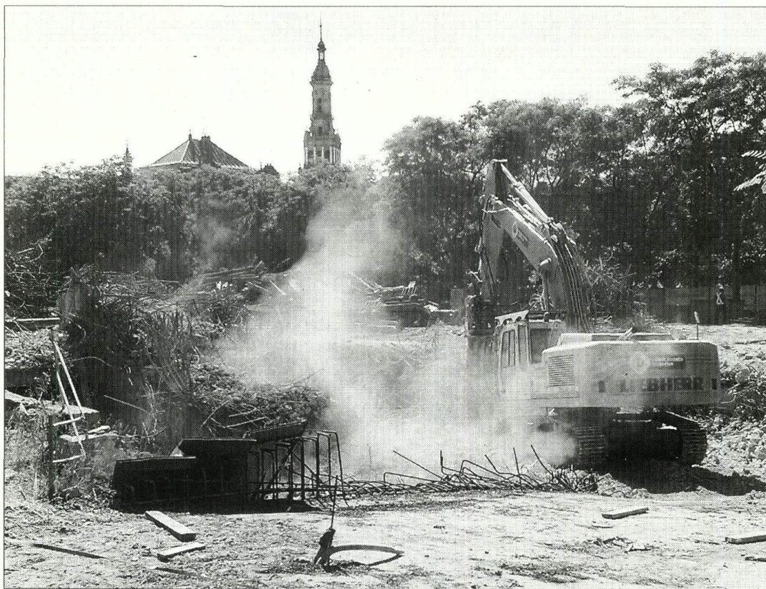
Los trabajos de demolición de los primeros pilares que se levantaron del proyecto de la biblioteca del Prado. / RAMON MORALES
