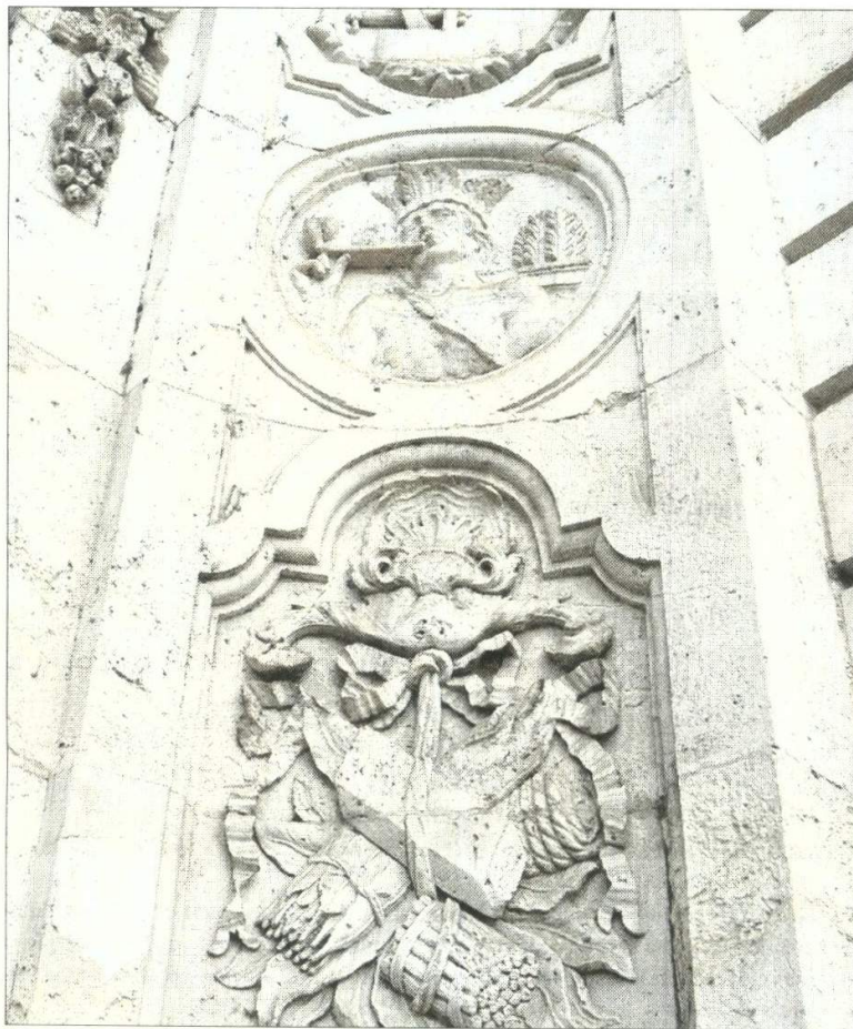
Detalle de uno de los relieves de la fachada principal del Rectorado. / L.R.
