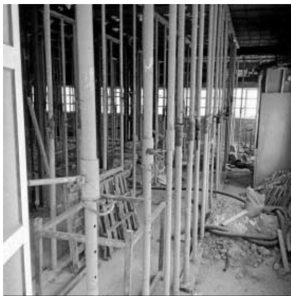
Área apuntalada del semisótano perteneciente al Instituto Anatómico.
