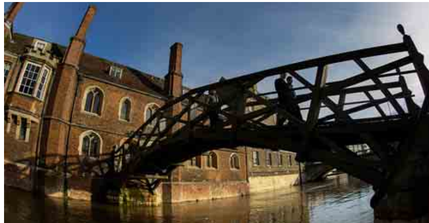
El puente matemático que une las dos orillas del Queen's College y supuestamente construido sin clavos.
