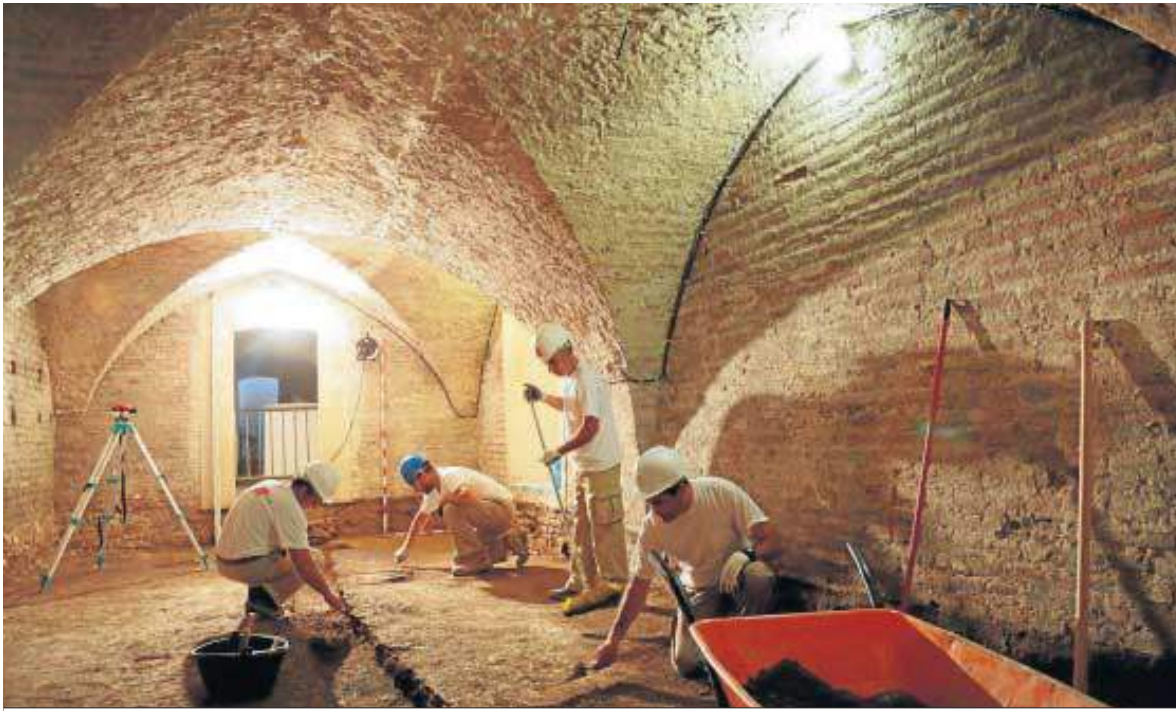
Los operarios, trabajando en la excavación que devolverá la estancia a su cota original.
