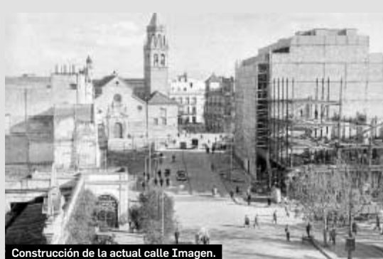
Construcción de la actual calle Imagen.
