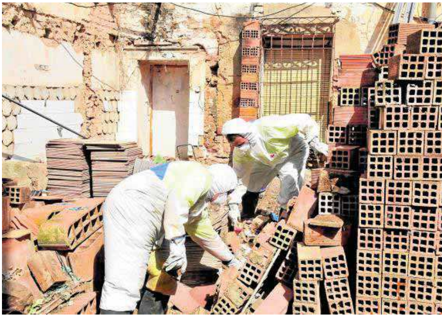
Trabajadores reconstruyendo una casa derruida en Linares. :: ENRIQUE
