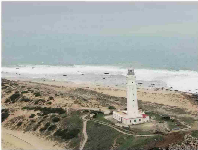
Vista aérea del Faro de Trafalgar. PACO ARIZA
