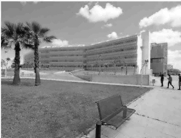
El edificio de la ETSI tras la conclusión de las obras.
