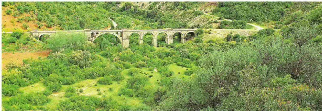
Viaducto de Coripe (Sevilla), en la Vía Verde de la Sierra
