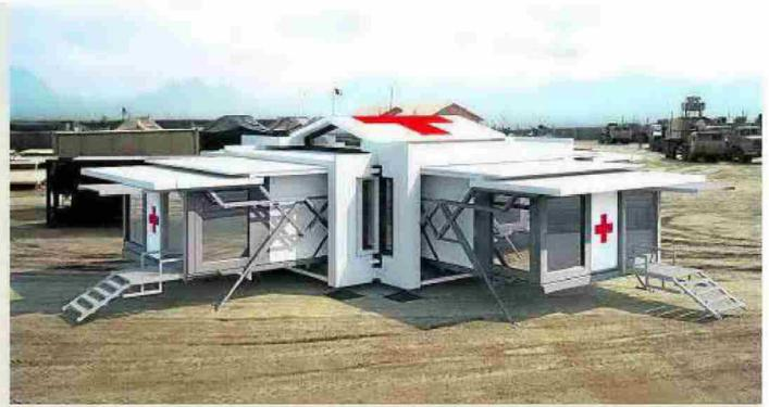
**Montaje.** La estructura modular, de apenas 9 metros de largo por 2,44 de ancho, multiplica su tamaño gracias a un sofisticado sistema de tornos, palancas y contrapesos. No requiere cimientos, ni siquiera un terreno llano para desplegar sus techos y paredes. **• R. C.**
